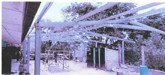
Foto 3: Cambio de Estructura metalica porque se encontraba en mal estado
