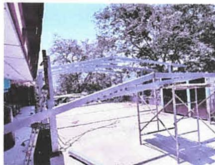
Foto 4: Cambio de Estructura metalica porque se encontraba en mal estado
